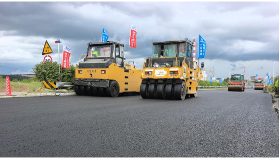
8月16日,中铁七局京漠公路项目顺利完成全线首个沥青试验段铺筑,成为大兴安岭地区全线首个完成沥青试验段铺筑的标段,标志着项目正式进入路面施工新阶段。(图/文 五公司 罗文誌)
