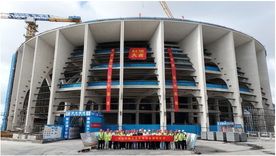
8月23日,中铁七局青岛市图书馆项目主体结构顺利封顶。该项目总建筑面积约3.5万平方米,建成后将成为新的青岛城市文化形象展示窗口。
