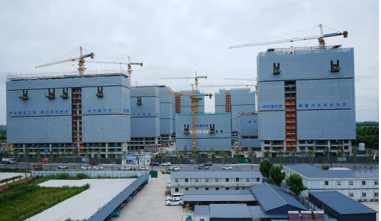
8月18日,中铁七局盐城凤依府项目1号、2号、3号、5号楼主体结构分部工程顺利通过验收。本次为项目首批完成主体结构验收的楼栋,其余楼栋仍按既定计划有序推进施工。(图/文 南京公司 文一)
