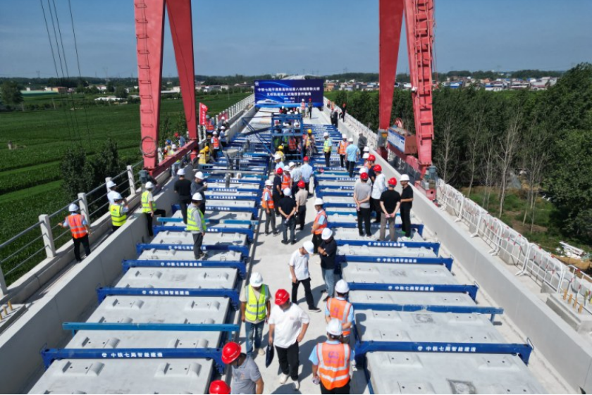
7月9日,中铁七局平漯周高铁商周特大桥CRTSⅢ型板式无砟轨道线上试验段首件工程通过验收。此次首件验收完成全线无砟轨道施工工艺、质量标准统一固化,为后续大面积规模化轨道施工提供标准化技术范本,有效降低施工试错成本,稳步推进平漯周高铁建设提速提质。(图/文 南京公司 罗鹏娟 李浩浩)
