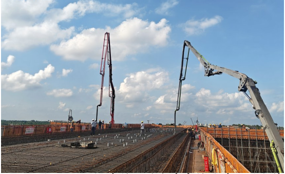
7月8日16时,中铁七局合武高铁塘埠口渚水特大桥598-600号墩十字连续梁浇筑完成,累计浇筑混凝土1630立方米。(图/文 四公司 季顺虎 刘佳玲)
