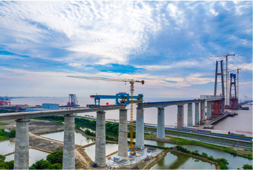
6月12日,随着架桥机将重达697吨的32米预制箱梁精准地落位到通甬高铁海盐特大桥992号墩与杭州湾跨海铁路桥1号墩上,标志着通甬高铁海盐段顺利实现“海陆会师”。截至目前,通甬高铁海盐陆路段总体进度已完成近70%。
