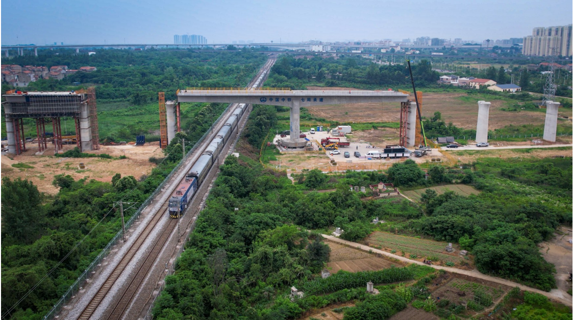
列车通过转体施工段(图/文 武汉公司 雷霄 冯苗蕾)
