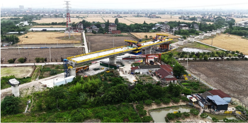
5月20日,中铁七局通甬高铁119.5米跨盐百线连续梁顺利合龙。该梁跨越既有公路,存在工期紧、安全质量及标准化施工要求高的难点。项目部组建专项管理团队,落实班子包保管控,优化施工工序、严控安全质量,实现梁体按期优质合龙。(南京公司 王丽鑫)
