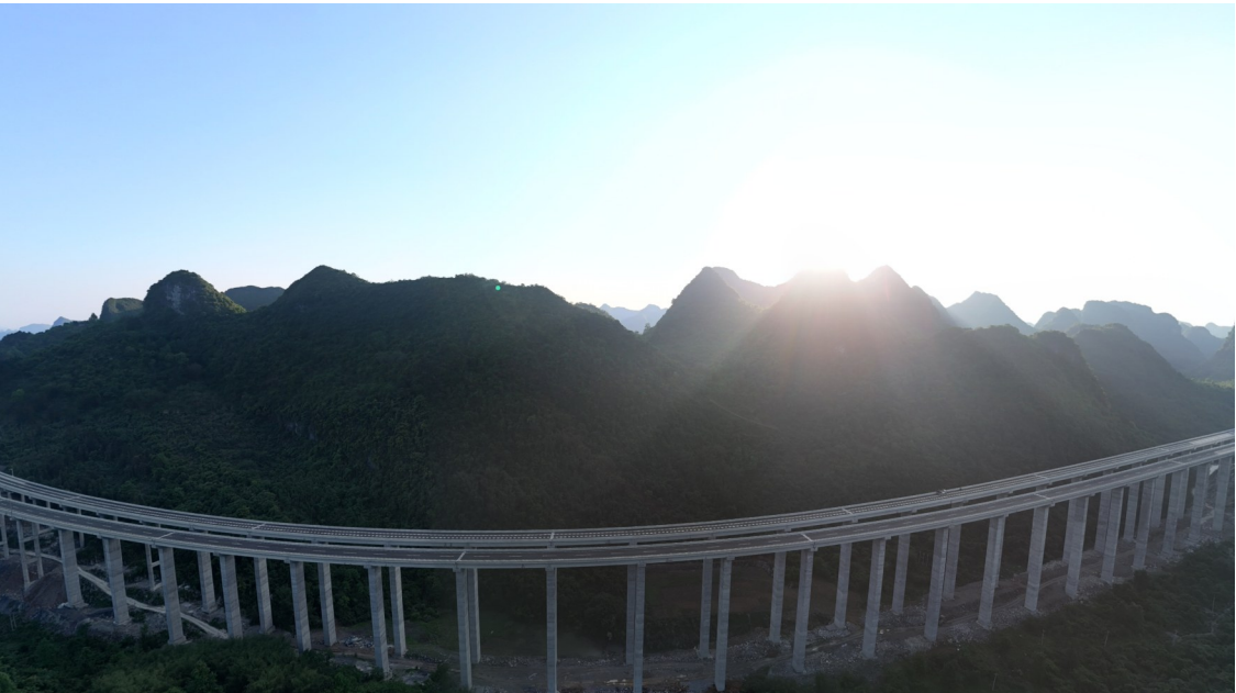
4月18日,随着最后一车沥青混合料碾压成型,由中铁七局承建的永柳高速公路全线沥青路面摊铺完成,全线通车进入倒计时。项目建成后,将进一步完善广西高速公路网及泛珠三角区域路网,推动区域经济发展、带动沿线产业及旅游事业发展。
