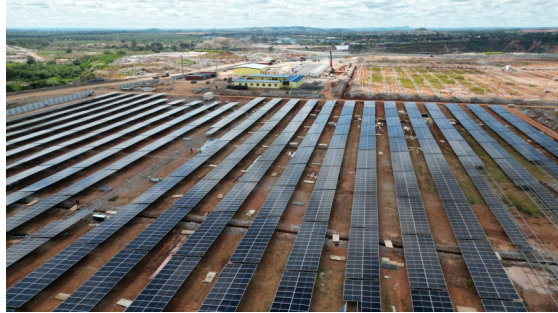
当地时间4月20日,中铁七局刚果(金)绿纱光伏项目首个光伏板子阵安装完成。该电站建成后,将为当地提供稳定可靠的清洁电力,助力能源结构转型与低碳可持续发展。
