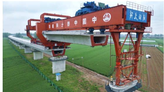
4月22日,中铁七局平漯周高铁完成土建范围内687孔箱梁的预制及架设重任,为后续无砟轨道施工、全线铺轨贯通奠定了坚实基础。
