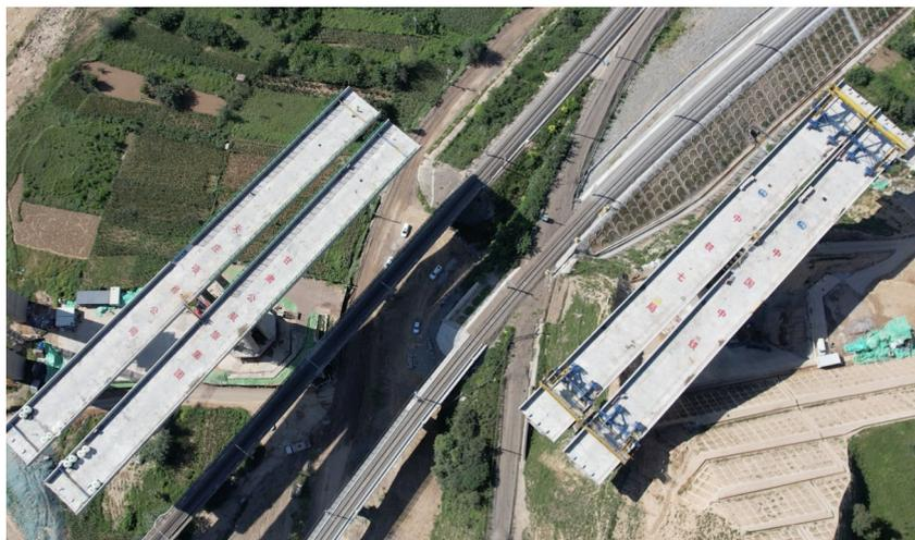
8月28日,中铁七局承建的静天高速公路天庄段两座2万吨的转体梁历经90分钟空中转体后精准就位。作为静天高速天庄段重点控制性工程,本次转体的高质量完成为后续工程建设奠定了坚实基础。(三公司 白稳超 摄影报道)
