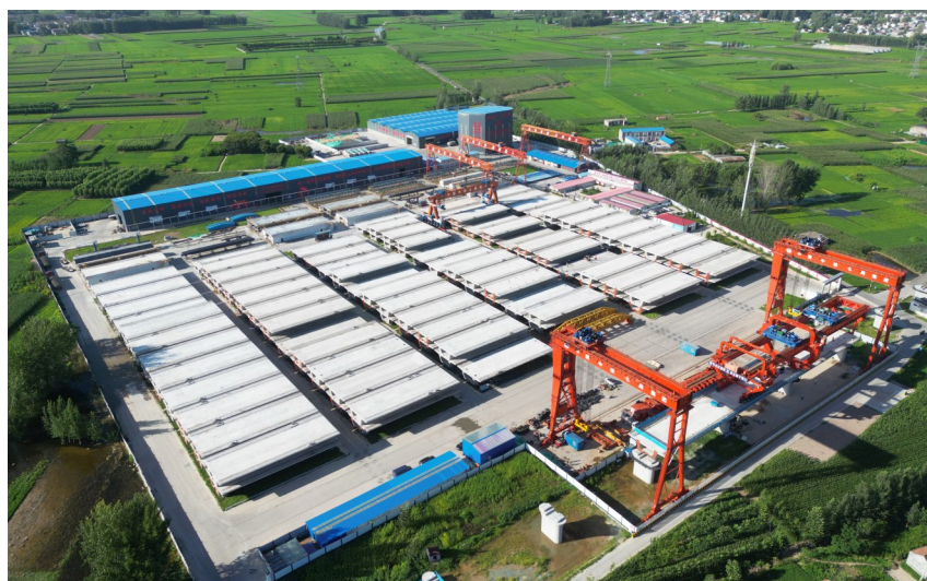
8月11日,中铁七局平深周高铁周口段首台自重530吨JQ900A型架桥机顺利拼装上桥完成,标志平深周高铁施工建设即将进入关键性铺架施工阶段。(郑州公司 杨佩华 摄影报道)
