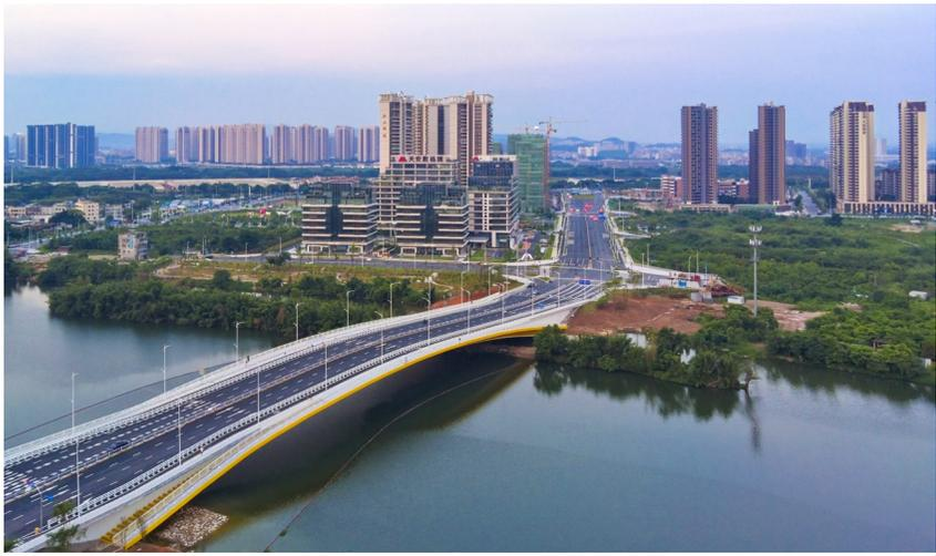
8月1日,由中铁七局承建的惠城区金山湖二号桥正式通车。作为市重点建设工程项目,金山湖二号桥于2022年8月底开工建设,原计划于2025年2月完工,在项目建设的高效管理下,提前半年实现了通车目标。金山湖二号桥全桥长度为273米,总宽40米,主桥宽3米,双向六车道,主桥为单跨上承式钢箱拱桥,设计净跨达到200米,跨度居全国前列。大桥采用机非分流通行模式,交通安全性极高。据悉,金山湖二号桥建成后对落实惠城区城市规划意图,改善城市投资环境,加快惠城区建设等方面有十分重要的意义,并有效缓解了片区的交通压力,提升了区域内的通行条件,为地方经济的发展注入了新的活力。(广州公司李璐 摄影报道)
