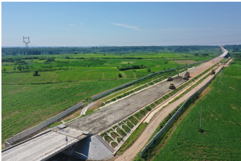
7月26日,合新铁路项目部首段路基完成填筑,为后续无砟轨道施工奠定坚实基础。(四公司 徐远宏 邹光涛 摄影报道)
