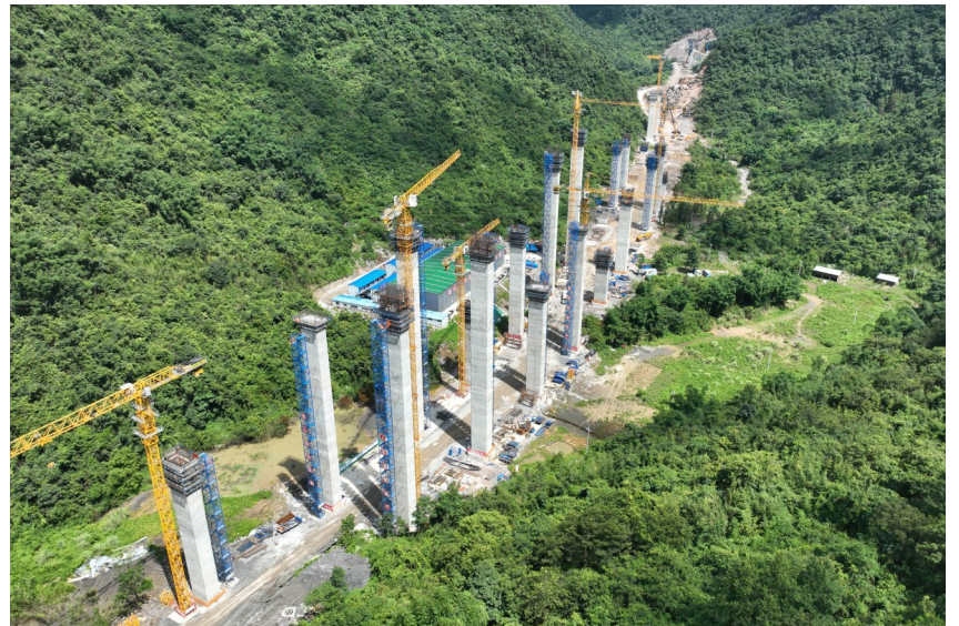
7月19日,中铁七局永柳高速控制性工程华山特大桥完成桩基施工,为项目顺利推进打下了坚实基础。(三公司 王浩 摄影报道)
