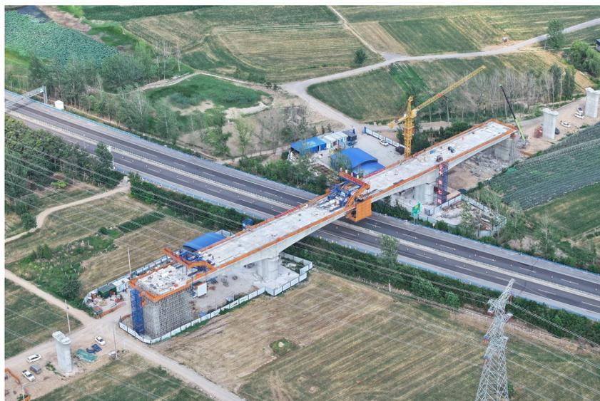
6月28日,随着最后一方混凝土浇筑完成,雄商铁路项目跨周高速公路连续梁顺利合龙,标志着项目建设取得新进展,为后续施工奠定了坚实的基础。(南京公司 张兆华 摄影报道)
