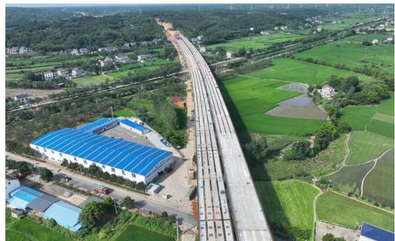
7月7日,由中铁七局承建的当枝松高速6标项目木天河大桥左幅预制箱梁架设圆满完成,标志着整个工程建设取得阶段性进展,为今年施工总体目标的实现打下了坚实基础。(武汉公司 曹曼 摄影报道)
