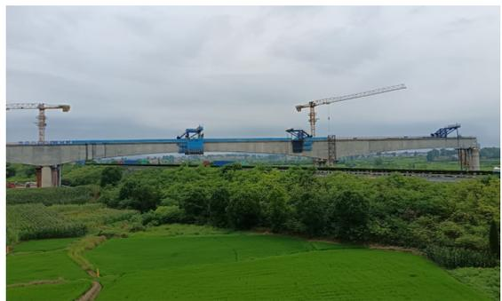
6月29日,由中铁七局承建的襄阳小河港区疏港铁路专用线小河港特大桥70m+128m+72m连续梁中合龙混凝土浇筑,经过近4个小时的有序施工顺利完成,为疏港铁路一期工程顺利竣工奠定了坚实的基础。(武汉公司 郭晓松 冯莹 摄影报道)
