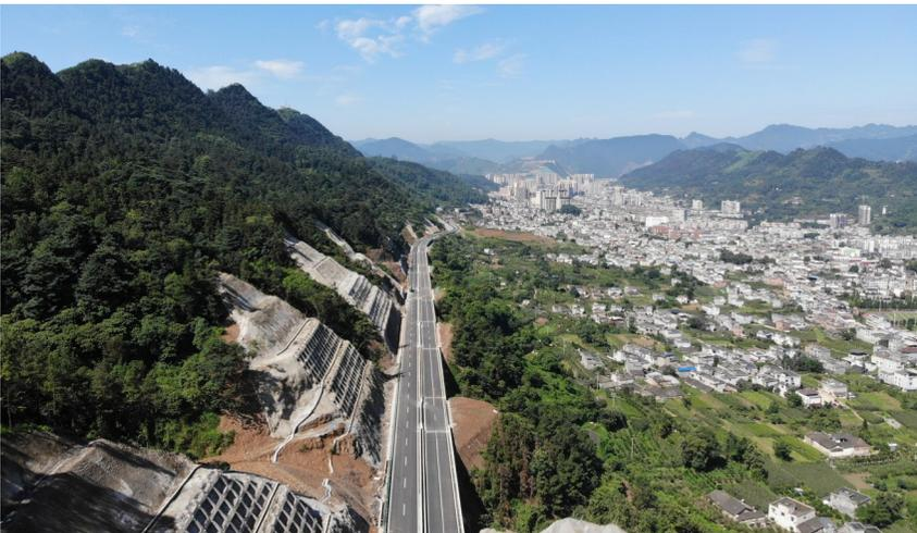
7月9日,由中铁七局承建的筠连北互通连接正式通车。筠连北互通连接镇红权村与北环路相接处,止于筠连北互通收费站,全长约3.9公里,为双向四车道,设计时速60公里。项目涵盖路桥隧施工,主要工程内容含分离式隧道1座和大、中桥8座,桥隧比达46.4%。(武汉公司 戴家宝摄影报道)
