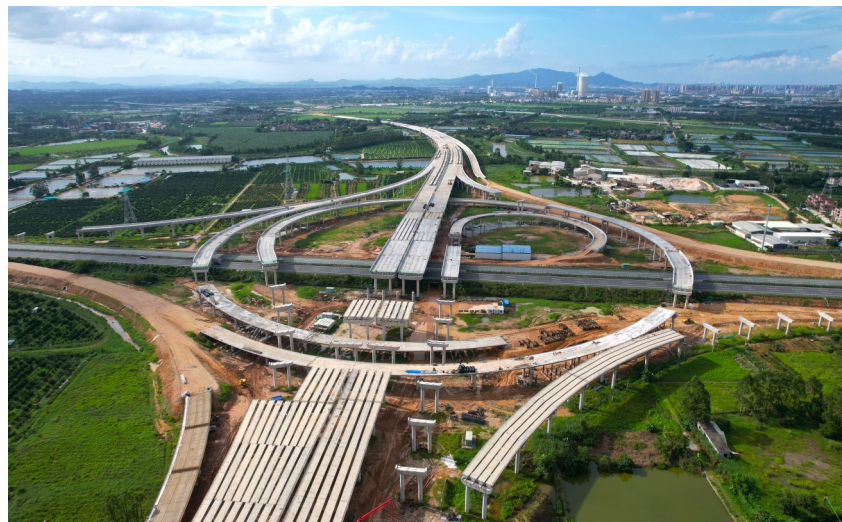
6月20日,由中铁七局承建的银洲湖高速公路TJ04标项目桩基工程全部完成,标志着银洲湖高速公路TJ04标项目全线施工进入了换挡冲刺阶段,距实现通车目标又迈进了关键一步。(广州公司 张戈 摄影报道)
