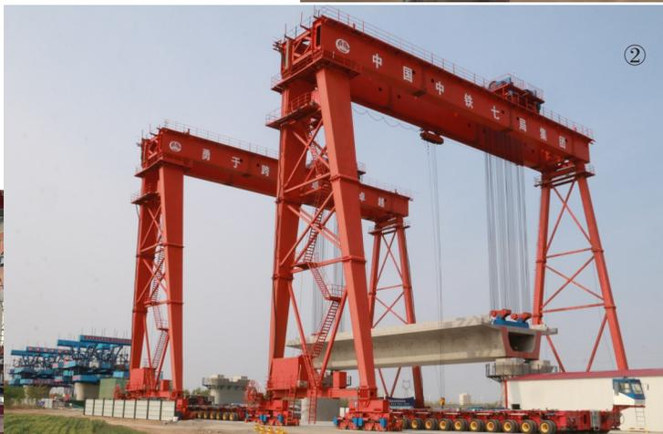
②五一前夕,中铁七局承建的津潍高铁站前三标滨海南特大桥首榀箱梁成功提吊就位,项目建设正式进入线上施工阶段,为后续架桥机上桥正式架设预制箱梁提供了详实数据。(三公司冯毅杨玉霞摄影报道)
