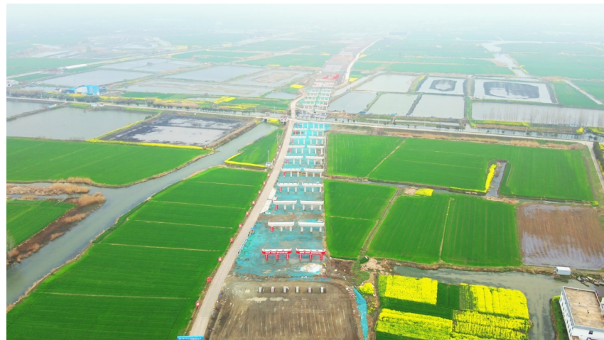
4月22日,西安公司承建的宁盐高速公路泰州段项目跃进河大桥墩柱及盖梁施工全部完成。目前,箱梁架设施工正在稳步推进。(西安公司 薛雯摄影报道)
