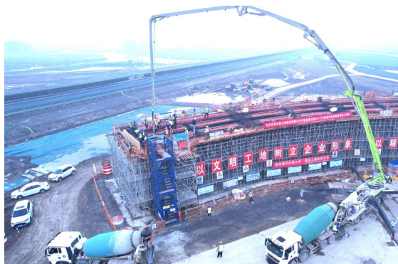
3月30日,中铁七局宁盐高速公路(泰州段)工程大墩枢纽C匝道桥第二联现浇连续箱梁首件顺利浇筑,标志着本标段正式进入桥梁上部施工阶段。该桥长381.60米,需现浇箱梁4联。(西安公司 薛雯)
