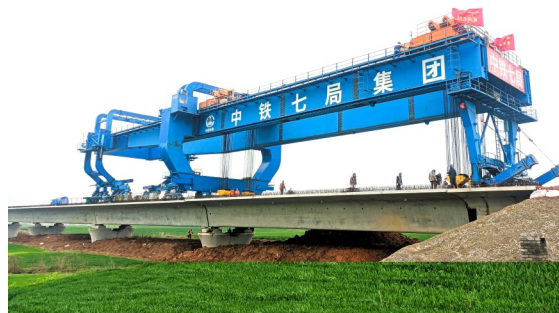
4月3日,由中铁七局合新铁路(安徽段)侯家特大桥箱梁全部架设完成,全长3.45公里,共计架设箱梁106孔。截止目前,该项目施工标段内跨京沪高铁、蒋庄、侯家三座特大桥、总长度16.54公里的箱梁架设完成。(三公司 沈小萍)
