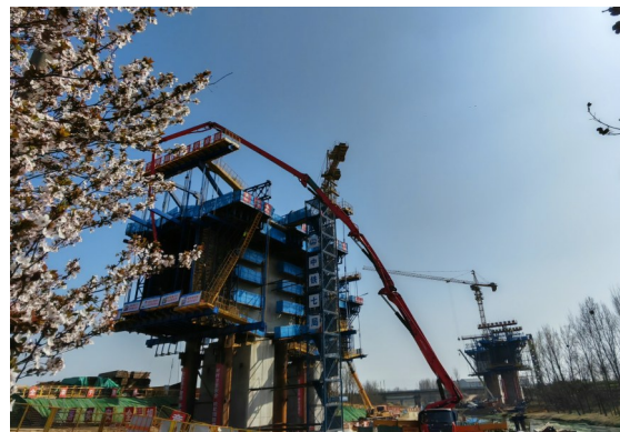
3月21日,中铁七局南邓高速项目连续梁首个标准节段浇筑完成。本次浇筑的连续梁首个标准节段为跨郑州市穰东镇赵河连续梁6号主墩1号块,共浇筑混凝土171立方米。(郑州公司 胡小虎)
