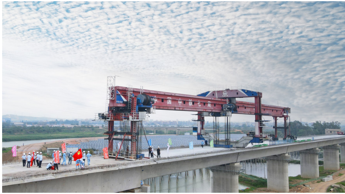
3月27日9时58分,随着1000吨低位过隧架桥机“陆吾号”将一孔900吨高铁箱梁稳稳落在广湛高铁梅江特大桥109号墩支座上,至此,历经760天的艰苦鏖战,广湛铁路八标茂名段1051孔箱梁架设任务顺利完成,高铁建设步入新的攻坚阶段。(广铁指翟刚 郑州公司武聚盟 摄影报道)
