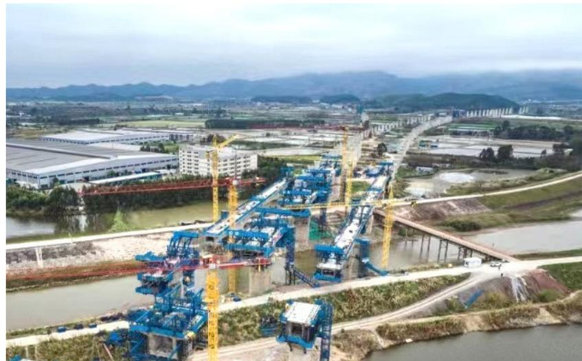
自春节假期结束复工复产以来，中铁七局珠肇高铁六标项目部不断优化施工组织，加大人员和物资设备投入，迅速掀起大干高潮，确保桥梁8月初合龙节点顺利完成。图为江机段高明特大桥正进行跨杨梅河连续梁施工。
