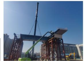
1月13日,西安公司南京市建宁西路过江通道B3 标段钢箱梁首节段成功吊装完成。该钢箱梁总重 2251.14吨, 跨径布置 56.5+63米, 纵向分为9个节段, 横向分为7片,共需吊装53次,单次吊装最大重量60 吨,采用500吨汽车吊进行吊装,施工难度大。
