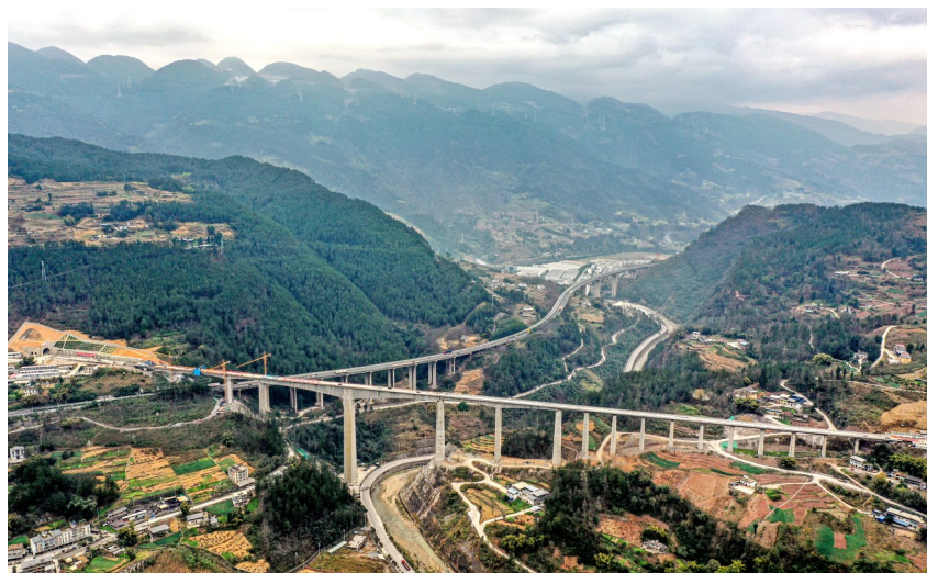
1月16日凌晨0时16分,随着最后一方混凝土的浇筑完成,由中铁七局承建的渝湘高铁重庆至黔江段石梁河双线特大桥梁全桥顺利贯通。该桥全长936.05米,共计18孔,19个墩台,其中4#墩T构桥梁是目前国内在建高铁项目中跨度最大的T构连续梁。(四公司 丁辉耀 王佩琪 摄影报道)
