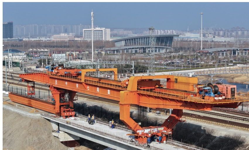
1月4日,随着最后一孔重达350吨的32米箱梁稳稳地落在139-140号桥墩上,标志着中铁七局承建的荷兰铁路项目河南段全线单、双线共计1293孔箱梁架设任务圆满完成,为后续全线铺、焊轨施工和静态验收奠定了坚实的基础,荷兰高铁建设取得了关键性胜利。(郑州公司王润宇 荷兰铁路指挥部 耿立 摄影报道)
