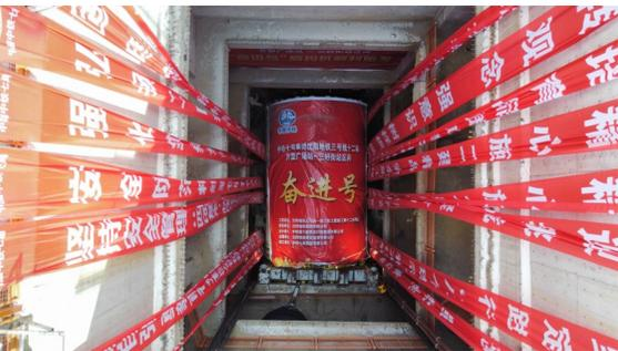
12月20日,中铁七局承建的沈阳地铁3号线12标方型广场站至三好街站区间左线“奋进号”盾构机顺利始发,该盾构机长88米,重400吨,开挖直径为6.44米,承担着方型广场站至三好街站区间共两条隧道单线1622.91米的盾构掘进任务。(二公司 周明飞)
