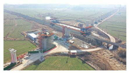
12月24日,由中铁七局承建的合新铁路项目天门村特大桥17#墩转体主墩9 号块顺利浇筑完成。天门村特大桥全长2038.21m,其中16-18#墩采用(48+48)m T 构转体跨越京沪铁路下行线,夹角为73°,是本标段的控制性工程。
