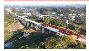
12月3日,南京公司沪渝蓉高铁项目谭家冲大桥 最后一榀箱梁顺利架设,标志着沪渝蓉高铁武宜段7 标杨家榜联络双线箱梁圆满完成架设任务,为后续无 砟轨道施工及桥面系施工奠定坚实基础。
