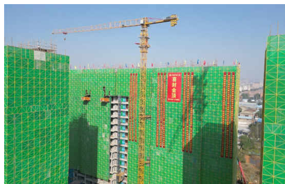
11月8日,郑州公司新密古城双洎河安置区一期工程12栋主体结构全部提前封顶。该工程建筑面积约为16万平方米,是新密市重点工程及民生工程。(郑州公司 赵亚龙 尼康)
