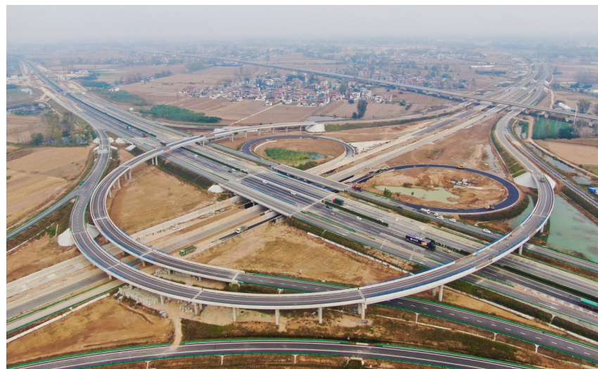
截至目前,由郑州公司承建的濮新高速62千米主线,47千米匝道,6个互通区及2个服务区水稳、沥青路面施工,按时圆满完成,为濮新高速12月1日全线开通打下了坚实基础。(郑州公司 吴国宇 摄影报道)
