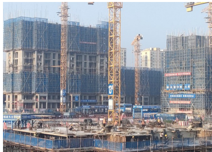
郑州公司冠县棚改项目施工现场
