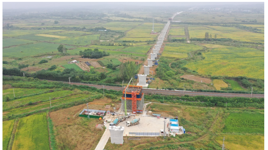
四公司合新铁路项目部天门村特大桥 43 号墩 0 号块浇筑
