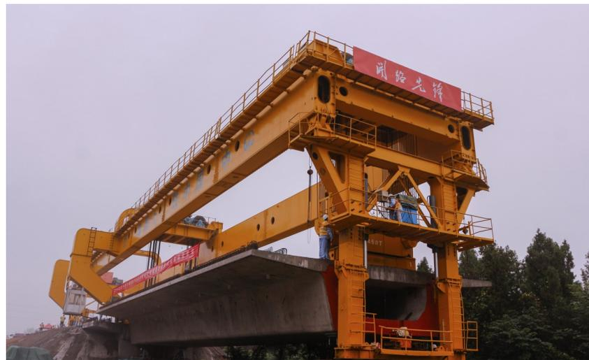
9月26日,郑开城际铁路延长线项目全线首榀箱梁顺利架设,为项目按期建成通车奠定了基础。郑开城际铁路延长线工程全长7.17km,共需架设双线箱梁91孔。(郑州公司 任朝辉 郑开城际项目部 蔡百顺 摄影报道)
