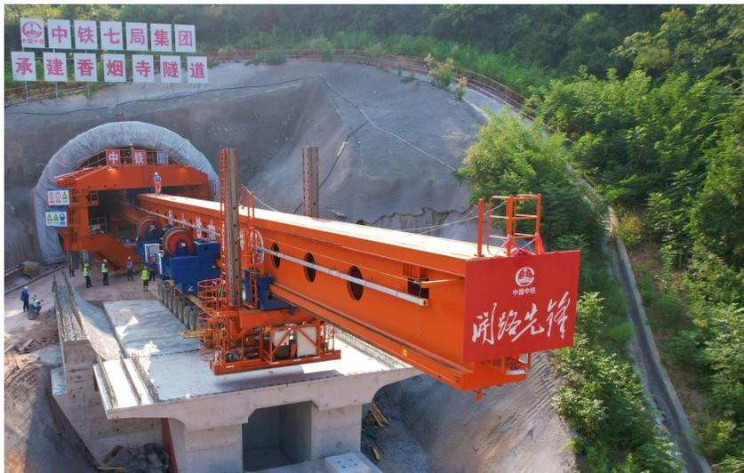
9月7日，武汉公司承建的新建沪渝蓉高铁武宜段7标架桥机首次实现整机过隧道，标志着标段内架梁任务正式转向隧道过渡段架设。本次架桥机所穿越的香烟寺隧道全长312.98米，是标段内9处整机过隧中的第一处。（武汉公司 王建勋 摄影报道）
