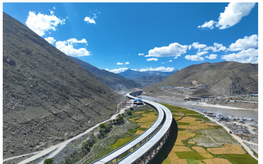
近日,郑州公司承建的西藏雅叶高速扎曲大桥左幅合龙,并完成2164片预制梁的架设任务,标志着雅叶项目全面进入冲刺施工阶段。进入三季度以来,项目部充分利用施工“黄金季节”气温高、日照长的特点,相继克服高海拔、多雨水等不利条件,积极组织推进施工进度,确保预制梁架设任务及连续梁施工安全、有效、按期完成。(郑州公司 阿继朝 摄影报道)
