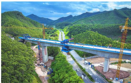
9月6日,中铁七局承建的珠肇高铁站前6标跨鞍山公路特大桥连续梁顺利合龙,这是珠肇高铁全线首座合龙的连续梁。施工过程中,项目部精心组织,狠抓安全质量管理,为连续梁合龙奠定了基础。(南京公司 关大乾 广州铁路工程指挥部 翟刚 摄影报道)
