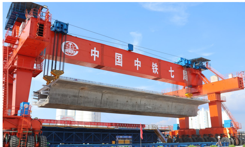
9月4日,中铁七局广湛铁路肇庆制梁场“第一梁”成功提运。采用MDEL1100t型轮胎式提梁机,该提梁机是目前国内高铁预制梁施工设备中最先进、起重量最大、跨度最大的新型轮胎式搬梁机,自重620t。此次首孔箱梁成功提运,标志着广湛铁路肇庆制梁场制梁工程步入正轨,达到短期内连续生产箱梁的条件。(三公司 汪子涵 摄影报道)
