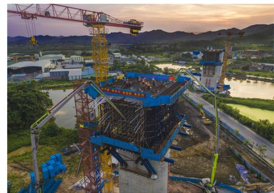
经过12小时的不间断施工,8月3日,中铁七局承建的珠肇高铁跨广明高速公路特大桥跨S297省道连续梁0号块顺利浇筑完成。该0号块为全线首个浇筑完成的跨省道连续梁标准节,共浇筑混凝土506立方米。
