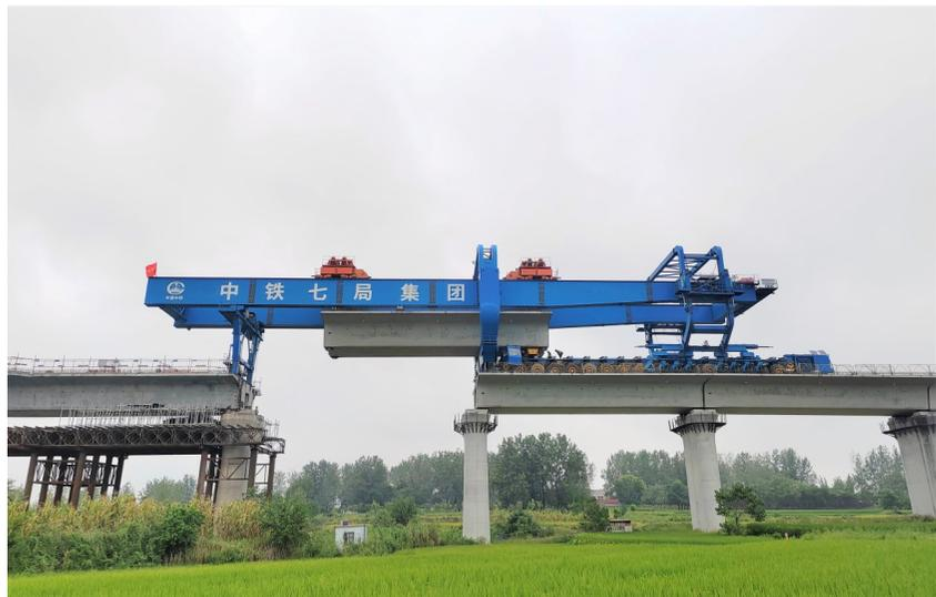
8月28日,随着最后一孔箱梁稳稳落在跨京沪高铁特大桥139-140号桥墩上,标志着中铁七局承建的合新铁路站前四标大里程方向箱梁架设任务圆满完成。此次大里程箱梁架设自蒋庄特大桥163号墩起至跨京沪高铁特大桥140号墩截止,全长8.9km,期间经过1.223km路基和跨明渠高速(32+148+32m)系杆拱连续梁,共计完成234孔箱梁架设。
