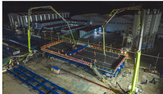
8月28日,中铁七局承建的广湛铁路机场段肇庆制梁场首孔箱梁顺利浇筑完成,标志着广湛铁路十二标“智慧型预制梁场”进入生产阶段,拉开了机场段桥梁上部结构施工的序幕。该制梁场占地面积约171.4亩,承担广湛铁路机场段371榀箱梁预制及架设施工任务,本次浇筑的第一片箱梁是猪垌山大桥第4孔梁,箱梁跨度31.5米,梁高2.8米,总重量约760吨。
