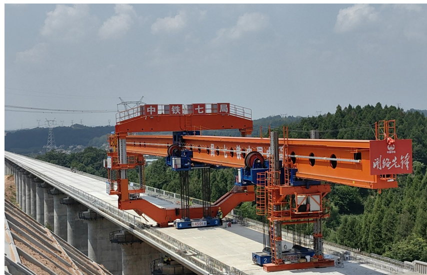
8月23日,随着一榀长24.6米、重达620吨预制箱梁精准落下,标志着由中铁七局承建的沪渝蓉高铁武宜段7标龙泉河特大桥顺利完成所有预制箱梁的架设任务。(武汉公司 王建勋 摄影报道)
