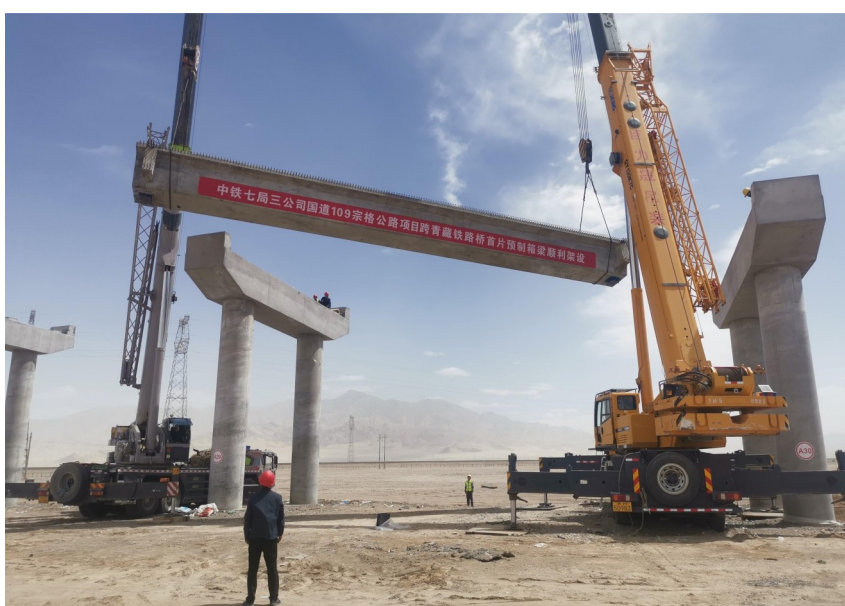
8月14日,三公司国道109宗格公路项目跨青藏铁路桥首片预制箱梁顺利完成架设,标志着该项目预制箱梁架体施工拉开序幕。此次架设的箱梁设计长度20米,重量55吨,采用两台大型汽车吊协同作业完成架设。该项目位于青海省海西蒙古族藏族自治州境内,是支撑柴达木循环经济试验区建设的重要基础设施,对促进柴达木循环经济试验区交通运输质量、内联外通、资源开发与利用,加快青海省、西藏自治区及项目沿线地区社会经济和旅游事业的发展以及对中国西部地区的平衡发展和稳定建设有着重要意义。(三公司 刘益航 摄影报道)
