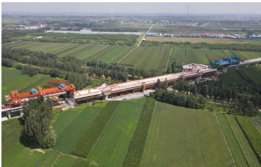
8月2日,随着两套900吨双线架桥机将兰考特大桥两跨长达822吨的32米箱梁精准架设就位,标志着由中铁七局承建的荷兰高铁河南段双线桥梁顺利贯通。
