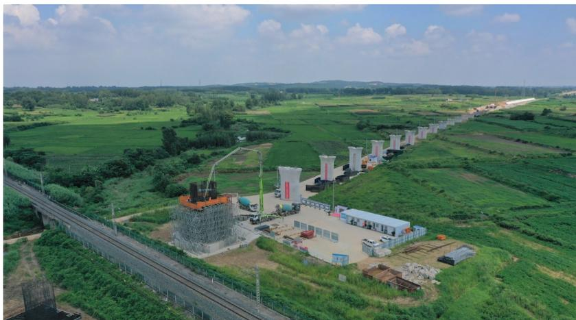
7月27日,随着最后一车混凝土泵入墩身,天门村特大桥17号主墩顺利浇筑完成,标志着合新铁路项目建设取得重大进展,为下一步梁体浇筑和桥梁转体施工奠定了基础。(四公司 陈苏摄影报道)
