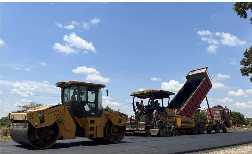
近日,随着海外公司赞比亚107项目沥青施工进度的快速推进和Nakonde市政段施工的展开,赞比亚各大媒体纷纷聚焦该项目的施工进度,引发当地大量网民关注、评论和转发。赞比亚107项目位于Muchinga省连接Isoka和Nakonde两镇,是赞比亚最主要的经济命脉之路——T2大北路靠近坦赞贸易关口的最后一段,承载了赞比亚人民对于加快基础设施建设的迫切期盼。项目采用改性沥青将之前既有破损严重的道路升级成双层沥青路面,道路宽度也由之前的9米拓宽至11米。(海外公司 林开童 陈荫 摄影报道)
