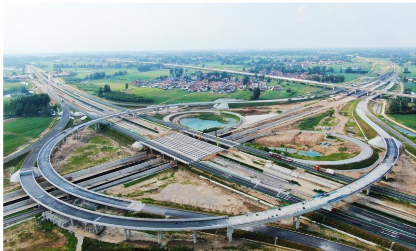
7月12日下午16时,随着最后一块预制箱梁精准对位,濮新高速下穿宁洛高速主线桥箱梁架设任务圆满完成。标志着濮新高速公路新安集枢纽互通施工进入最后攻坚阶段。(郑州公司 巩云鹏 摄影报道)
