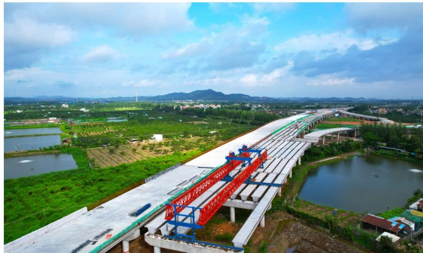
近日,随着银洲湖高速朱村互通立交主线桥左幅最后一块25米预制箱梁平稳精准落位,标志着公司银洲湖高速公路朱村互通立交主线桥双幅顺利贯通。该桥是全线重难点、控制性工程,长1060米,共41跨,桥梁最宽处32.11米,上部结构均为预制小箱梁,下部结构采用柱式墩,桥台采用座板台,基础采用钻孔灌注桩。(一公司 马文辉)
