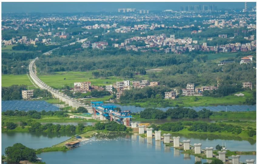
6月11日凌晨4时,随着最后一方混凝土成功浇筑,由中铁七局承建的广湛铁路梅江特大桥跨梅江连续梁顺利合龙,标志着广湛铁路茂名段所有连续梁主体施工全部完成,为广湛铁路如期通车奠定了坚实基础。新建广湛铁路梅江特大桥全长7396.32米,横跨湛江和茂名两市,桥梁经过处地形复杂,是全线控制性工程之一。(郑州公司 赵俊卿 摄影报道)
